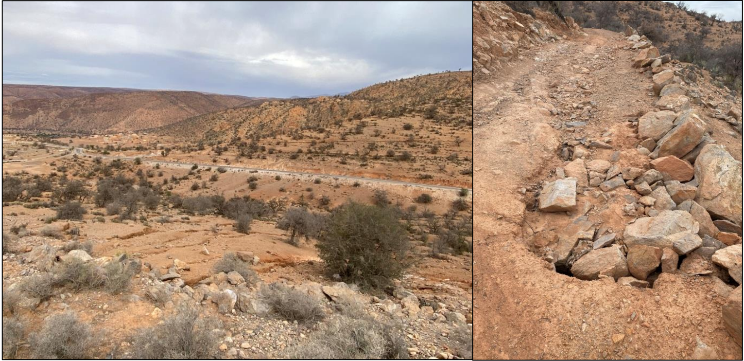
الصورة 2: مظاهر التخذيد الأولي وانحيارات بجوانب الطرق
