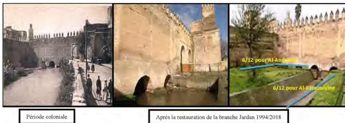
Fig 1 : Voûtes de Fès (Sources : Espaces, Revue de Géographie – N°6-7/2019)
